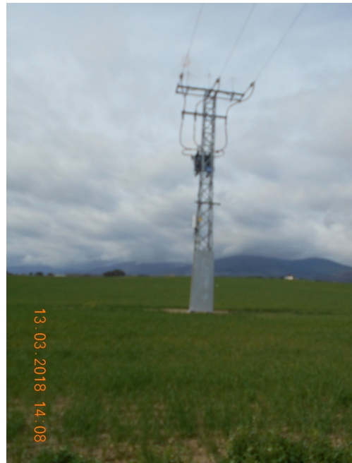
Nuevo apoyo metálico dentro de la parcela con el transformador
